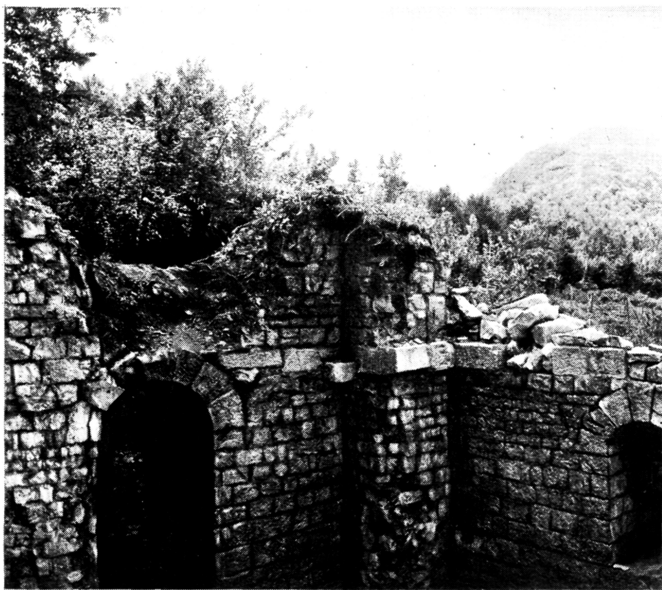
Рис. 17. Вид на башню 3 с севера
