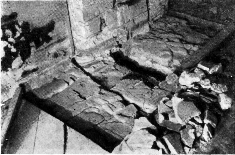
Рис. 2. Деталь примыкания восточной стены северо-западной башни к западному торцу внутренней северной галереи в уровне хоров.
