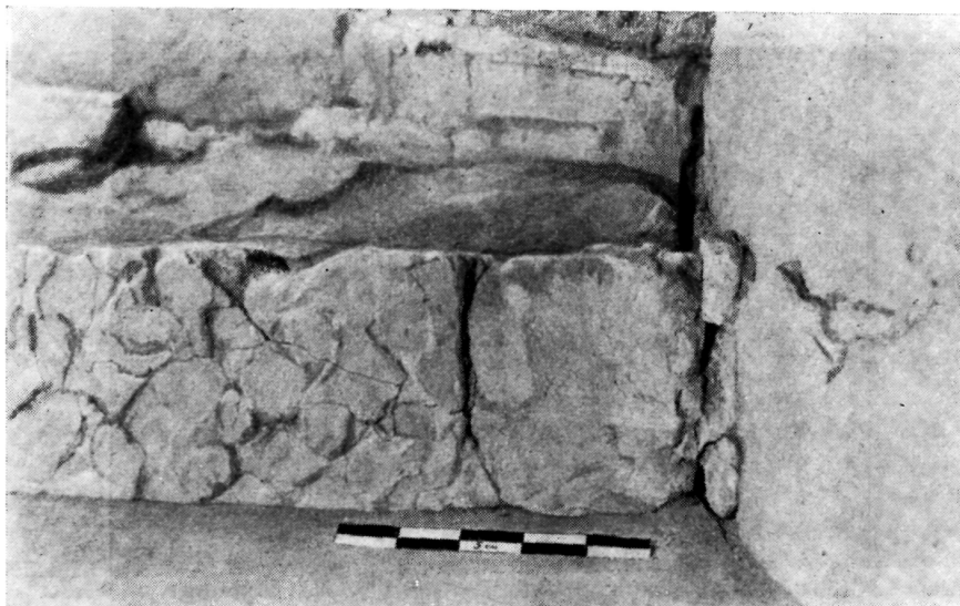
Рис. 12. Деталь примыкания подступенка 14-й ступени к столбу башни.
